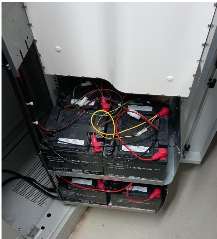
Abbildung 11: Akkus für USV im 19'' Rack
