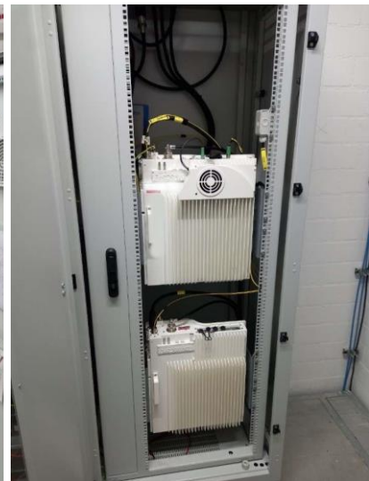
Abb. 32: Montage OV-Stecker mit aktiver Lüftung im 19“ Schrank (oben)
