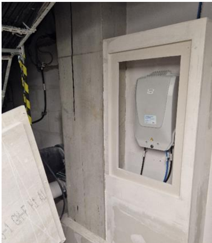
Abbildung 9: Brandschutz-Verkleidung APL
