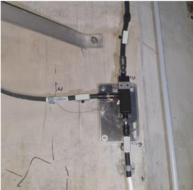
Abbildung 8: Koppler sowie andere Komponenten sind leicht zugänglich an der Wand zu montieren
