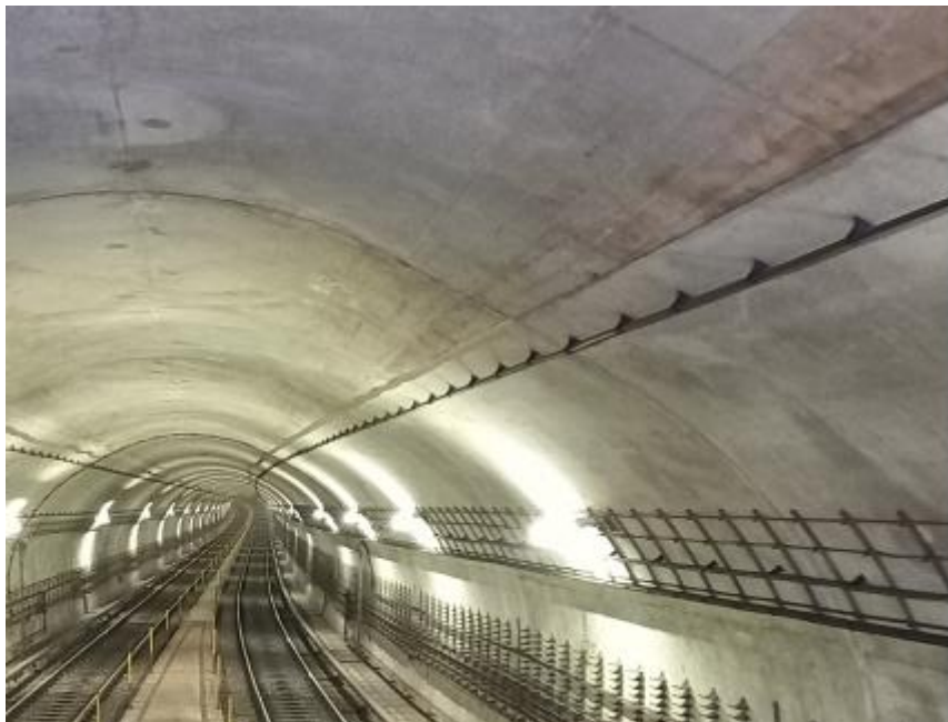
Abbildung 7: Strahlerkabel an der Decke mit Abstandshaltern montiert
